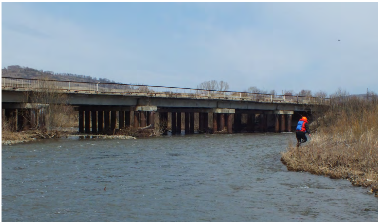
Фото 04.15. Алексей снова на разведку. Весь поток бьет под ПБ, в крайнюю опору моста, там торчат балки и бетонные блоки. Прошли между двумя крайними справа опорами моста, отрабатывая постоянно влево
