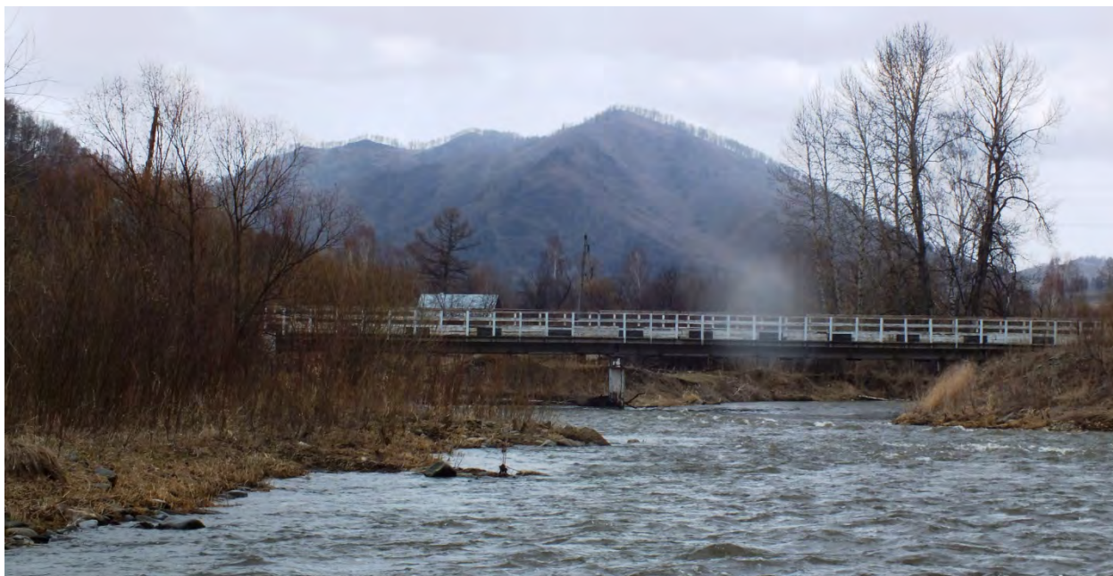
Фото 03.33. В районе п.Таурак проходим подряд два моста
